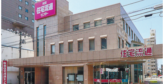
秋田市大町の赤れんが館通りに立地する拠点「大町ビル」
